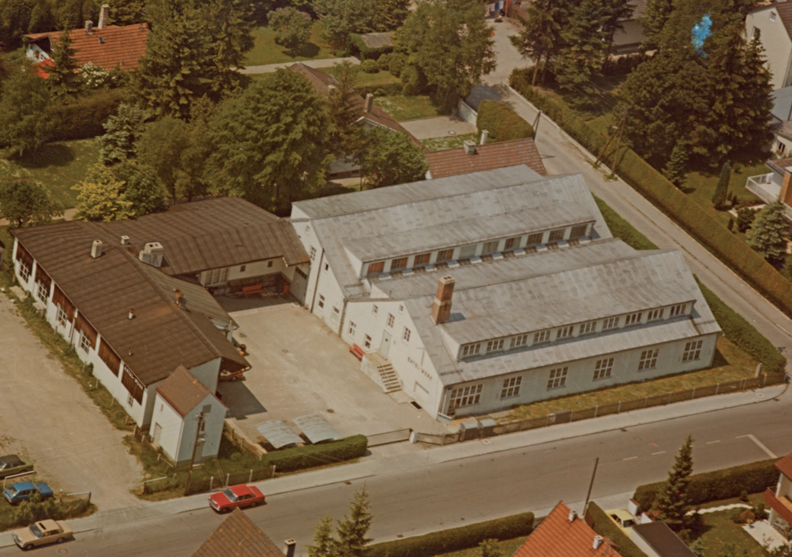
Das Ertel-Betriebsgelände in der Gröbenzeller Straße 13 in Puchheim im Sommer 1978. Die Doppel-Werkshalle rechts beherbergte von 1948 bis 1955 die „Hess-Musik“. (Foto: Bayerisches Wirtschaftsarchiv)
